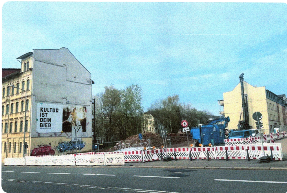
An der Ecke von Leipziger Straße und Kanalstraße starten die Bauarbeiten für die neue Wohnanlage. Foto: Christian Mathea
